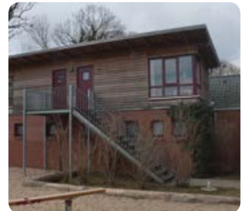
Neue Gebäudeteile in Schönhagen.
